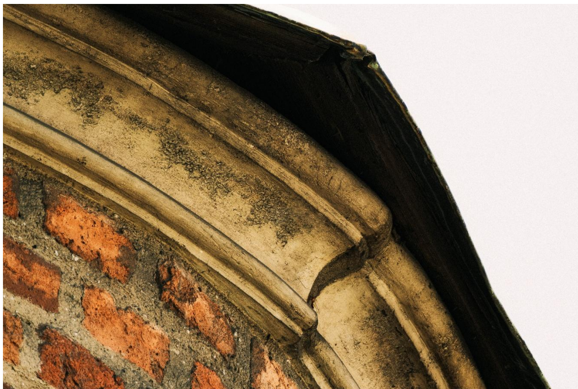
Profil kamienny wieńczący wieżyczkę, widoczny pas deskowania oraz zaklepana blacha miedziana stanowiąca poszycie
