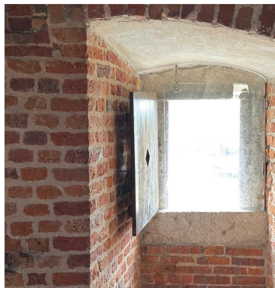
Przykład zamknięcia otworu okiennego na Wieży Sandomierskiej na Wawelu (Kraków)
