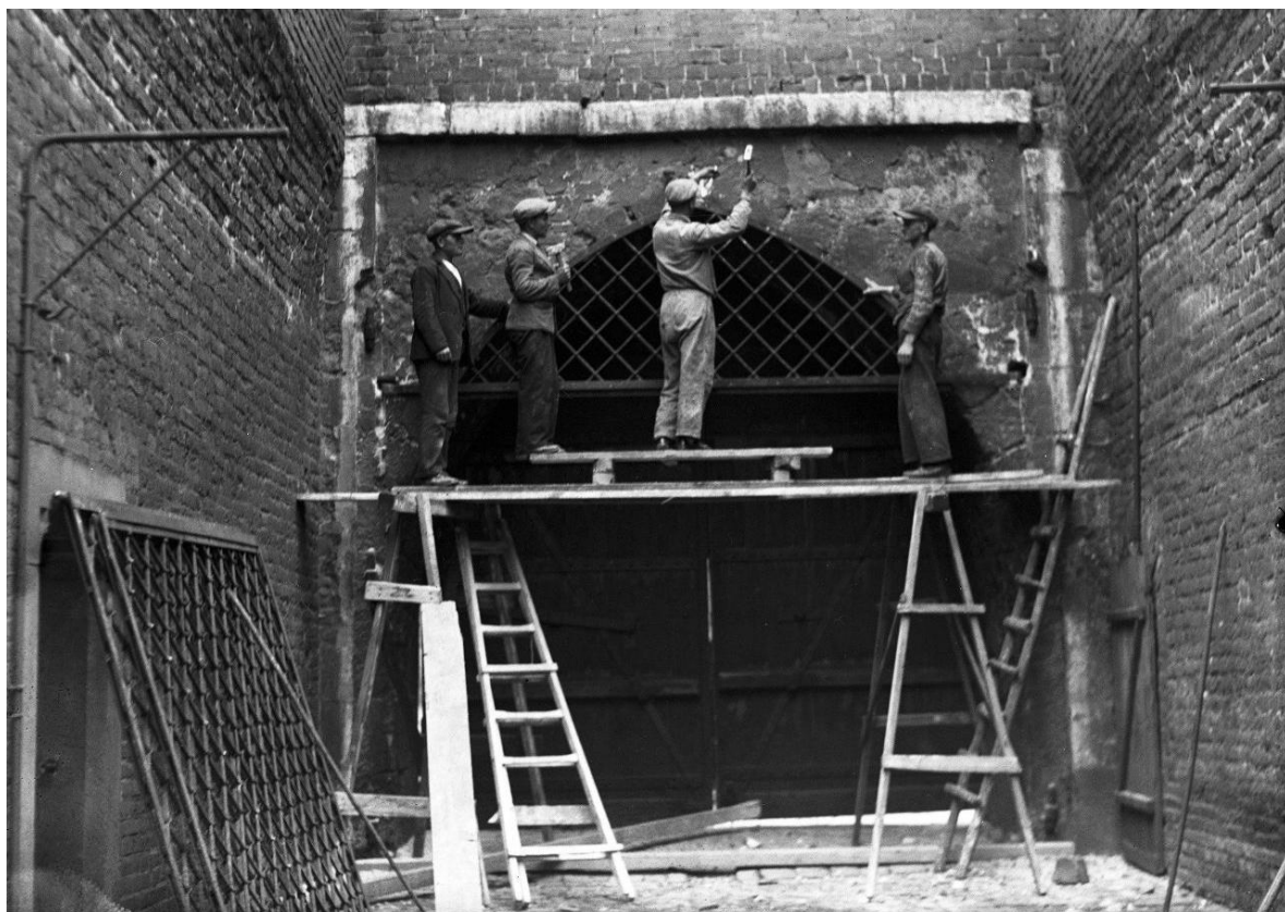
Prace remontowe, lata 30-te XX wieku, Brama Kremerowska (montaż kraty od wnętrza – naświetle zamontowane, skrzydła po lewej stronie wsparte o ścianę Szyi [Źródło: NAC, dostęp kwiecień 2025 r.]
