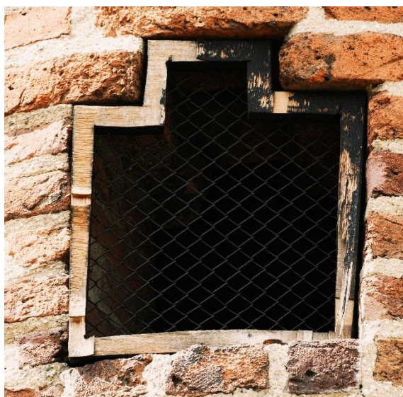
Zamontowane siatki w okienkach strzelniczych na wieżyczkach – element do powtórzenia celem zabezpieczenia przed dostępem ptactwa do ich wnętrza
